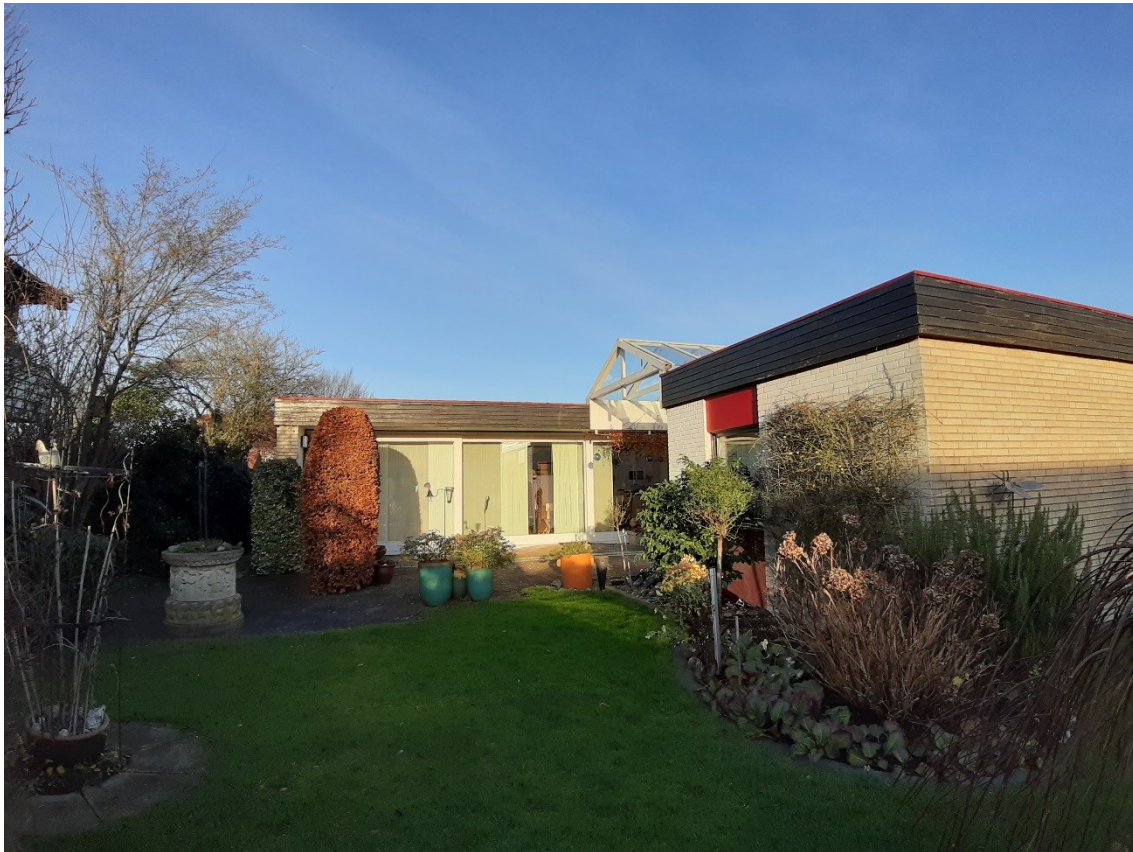
Ansicht aus Süd-Westen auf die Rückseite
