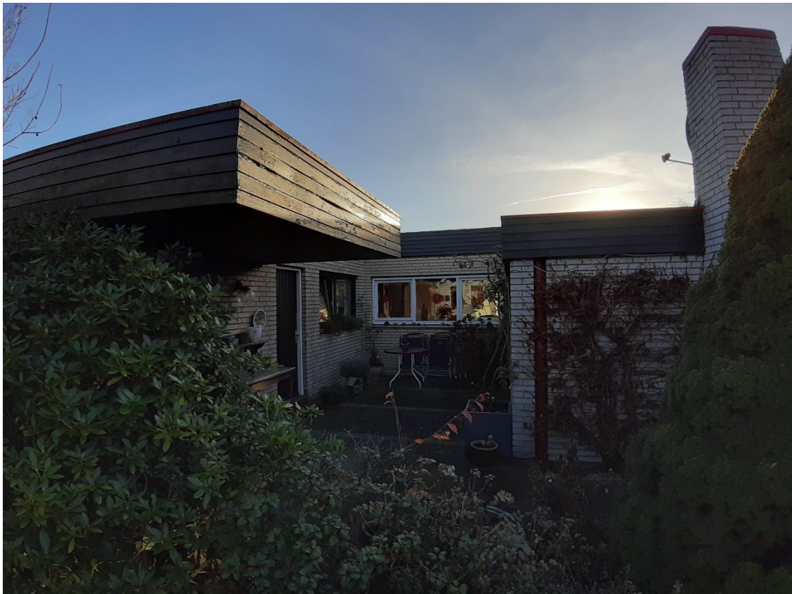
Ansicht Nordseite vom Nachbargrundstück auf den kleinen Innenhof mit den Esszimmerfenstern
