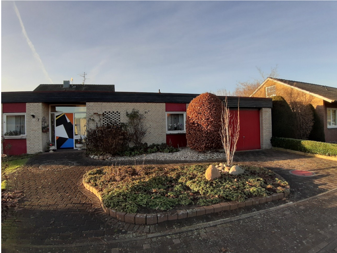
Ansicht von der Straße auf den Hauseingang
